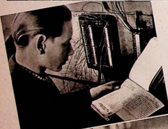
Bei der Ausbildung der Fernmeldemonteur- und Fernmeldebau-Lehrlinge wird besonderes Augenmerk auf das Löten gerichtet. Links: Auch das Schaltplanlesen gehört mit zur Grundausbildung. Unser Bild zeigt einen Lehrling, der an Hand eines Plans Leitungsverbindungen an einem Kabelverteiler vornimmt
